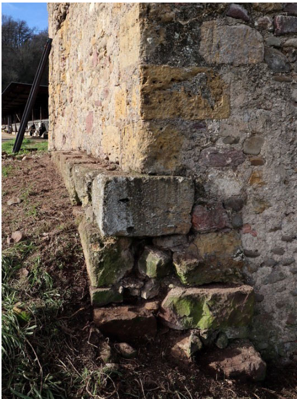
Rupture du mur initial à l'angle nord est du bâtiment.
