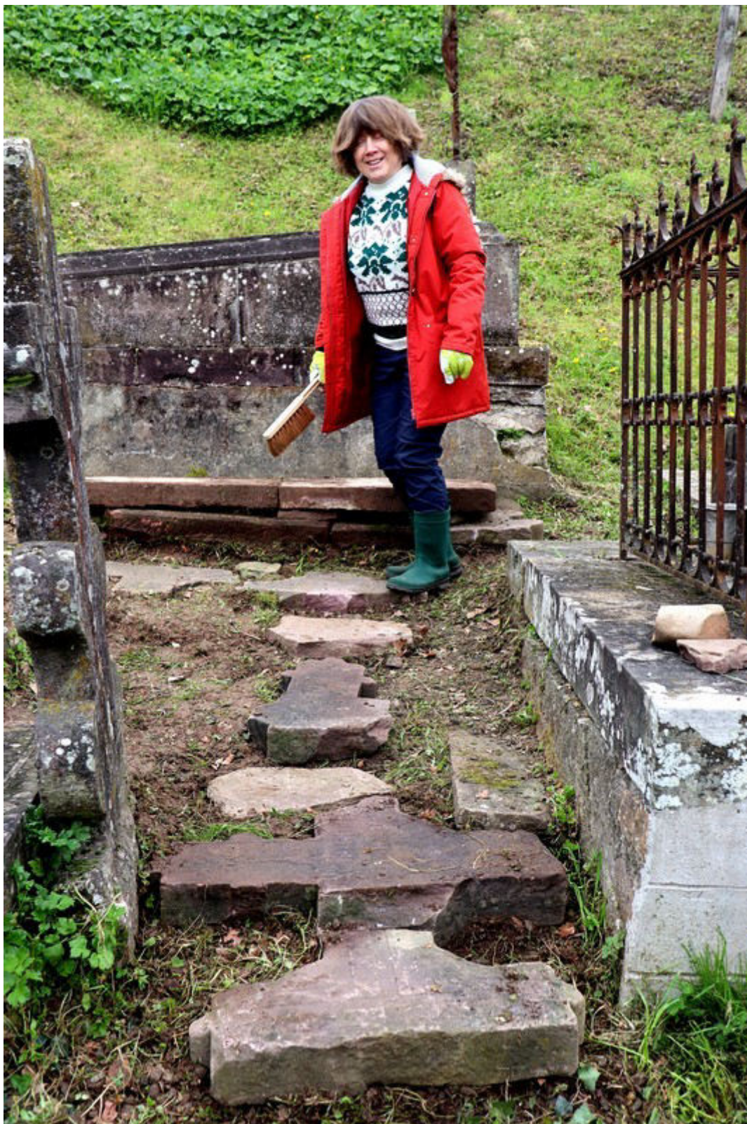
Le nouveau banc et son pas japonais en cours d'installation
